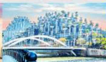
อาคารฟันทันไม
